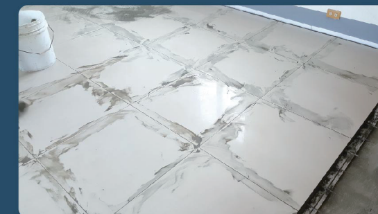
▲ 磁磚縫隙及牆面接縫進行填縫處理
