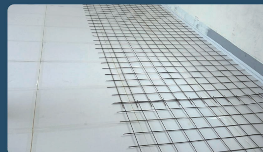
▲ 將點焊鋼筋或玻璃纖維固格網置於台達波特板上
